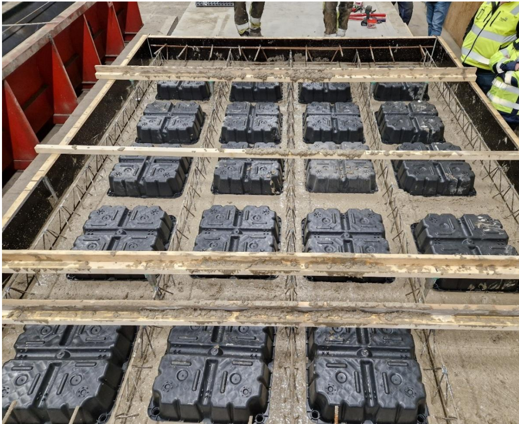
Figur 5. Utformning av bjälklag med sparkroppar.
