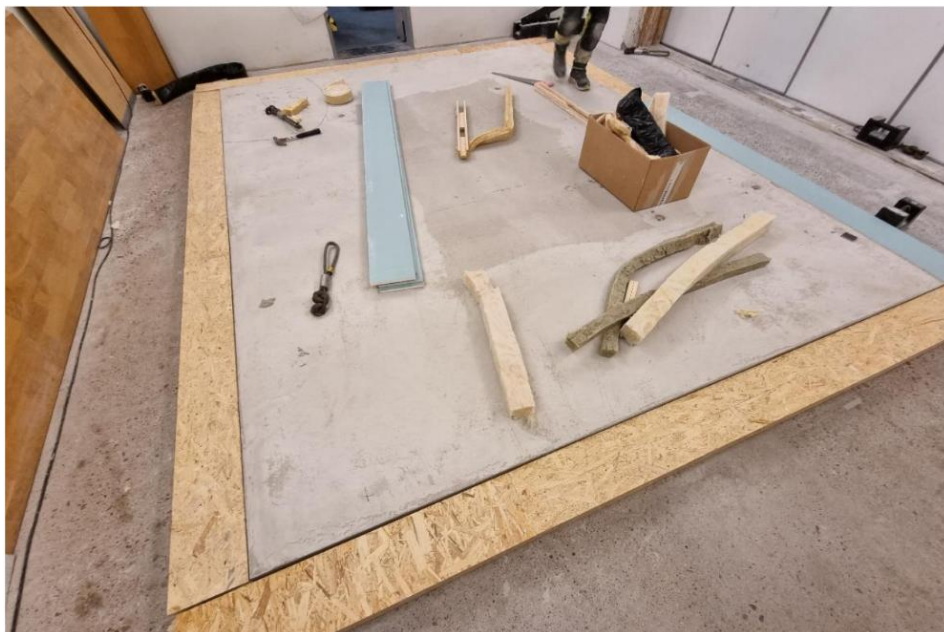
Figur 8. Provobjekt monterat i provöppning. Byggnation av sarg runt bjälklagskant.
